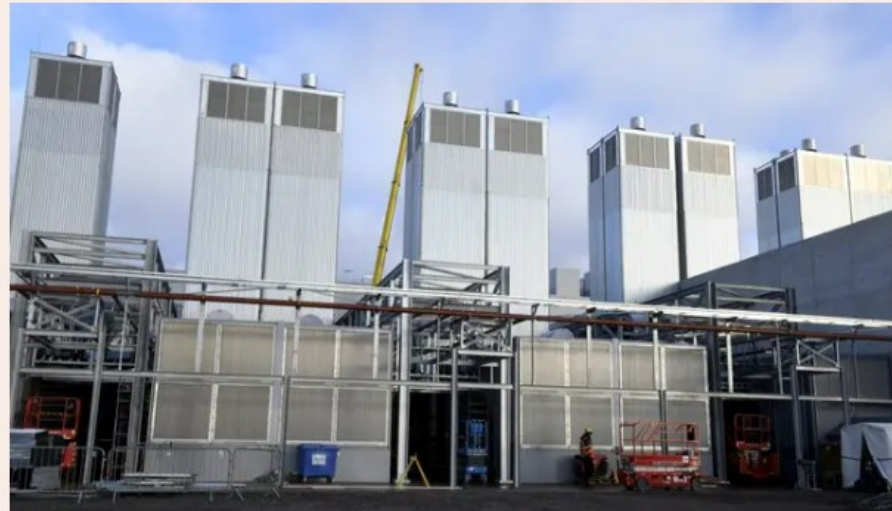
Googlen datakeskuksen laajennustyömaa Haminassa vuonna 2020. Kuva: Heikki Saukkomaa / Lehtikuva
