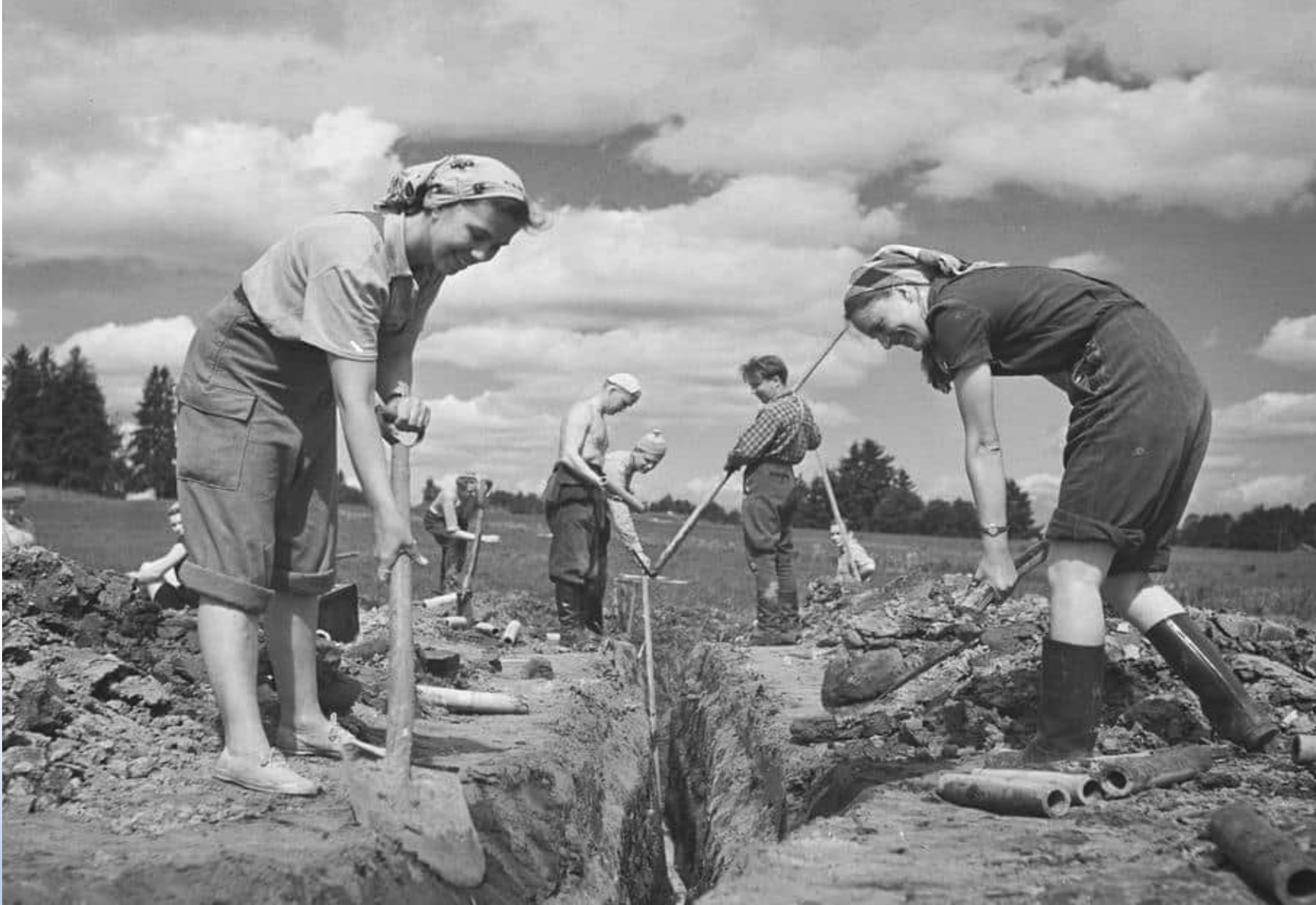
salaojitus käynnissä Ylistaron kylässä Kokemäellä, Kyytinen, Pekka, kuvaaja 1952, Organisaatio: Museovirasto, Kokoelma: Kansatieteen kuvakokoelma, Pekka Kyytisen kokoelma
