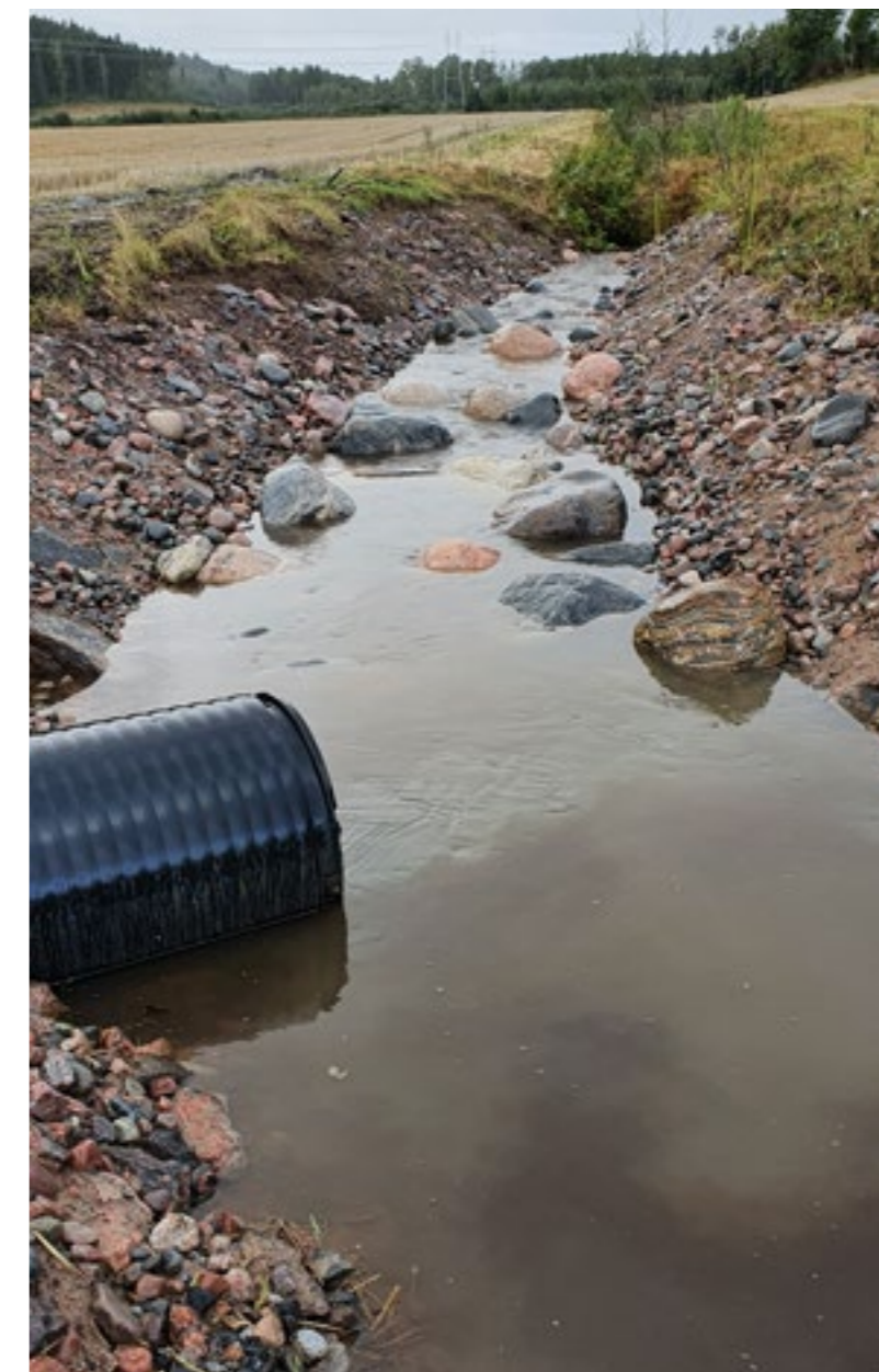
KUVA: AIRI KULMALA
