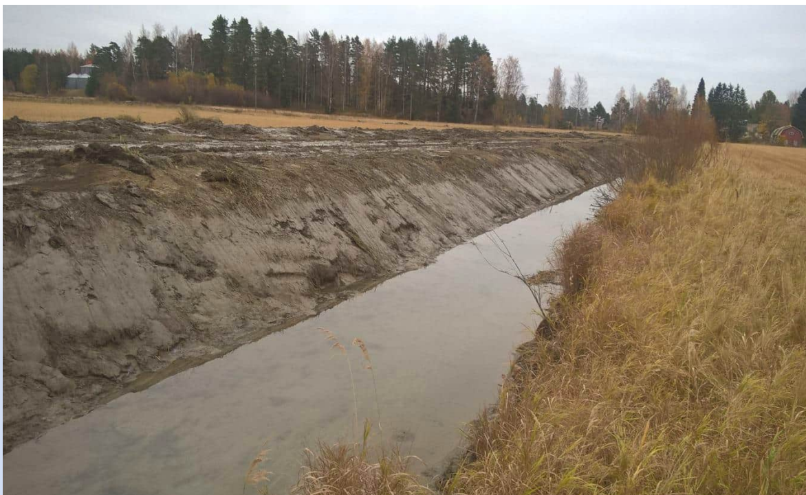
Toispuoleinen varovainen kaivu
